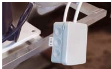
szczelna kosta przyłączeniowa do elektryczności
